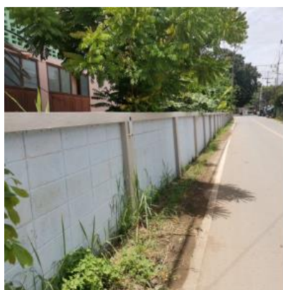
รั้วคอนกรีต ประเภทสิ่งก่อสร้าง รั้ว อายุการใช้งาน 27 ปี
