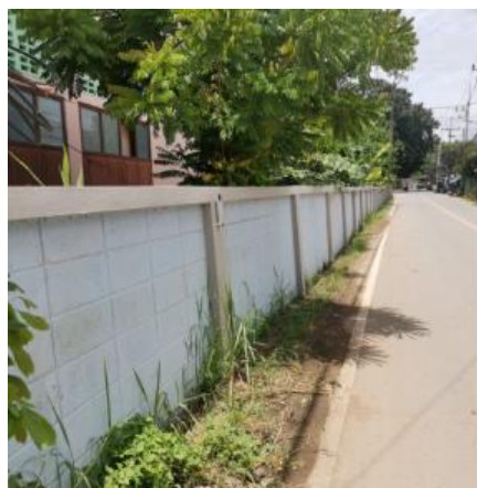
รั้วคอนกรีต ประเภทสิ่งก่อสร้าง รั้ว อายุการใช้งาน 27 ปี
