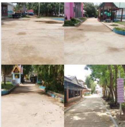
ถนนคอนกรีต ประเภทสิ่งก่อสร้าง ถนน อายุการใช้งาน 4 ปี
